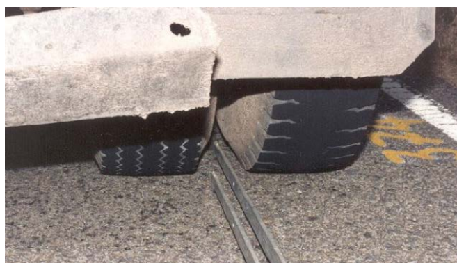
Figura 795 - 5. Colocación de la viga doble
